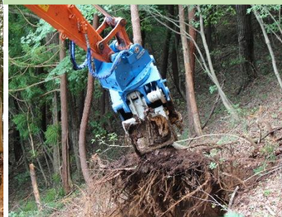
【除根・埋め戻し】
