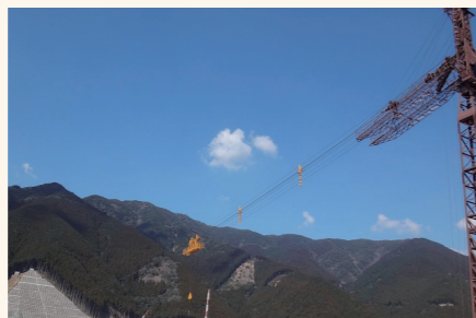
[ ケーブルクレーン ]
