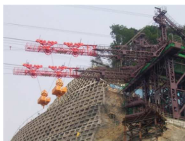
山間部での資材運搬設備 (ケーブルクレーン)
