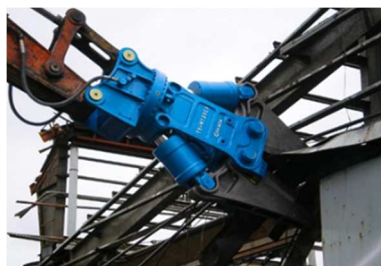
ビル解体用建機 (鉄骨カッター)
