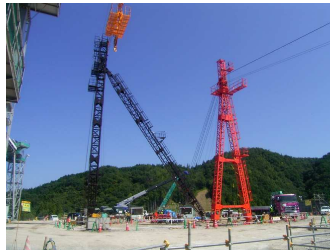
ダム建設用ケーブルクレーン
