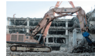
解体用機械(大割機)
