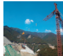
ケーブルクレーン
