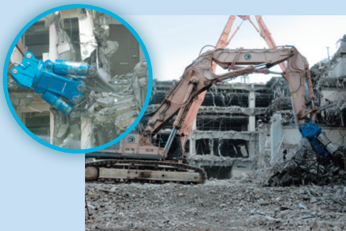
▲解体用機械（大割機）
