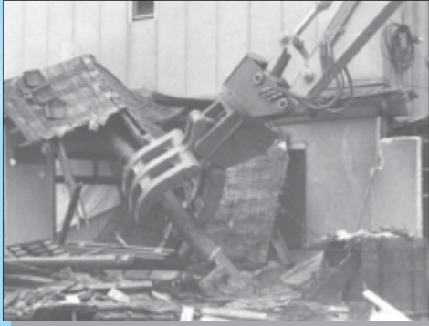
木造家屋の解体作業に
