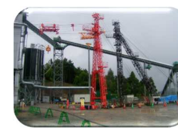
水力発電改修用運搬設備 ケーブルクレーン
