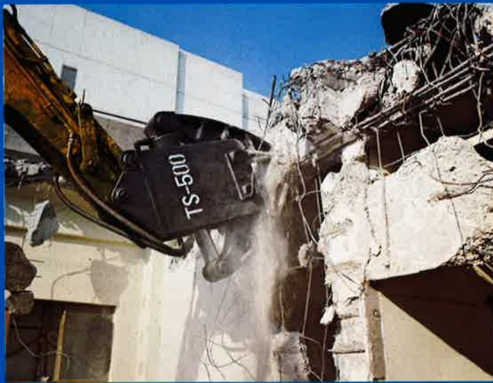
▲ ハリの下の部分からの作業
