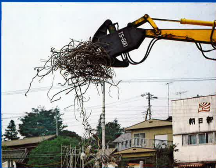
▲ 鉄筋の集積・トラック積込み スピードアップ
