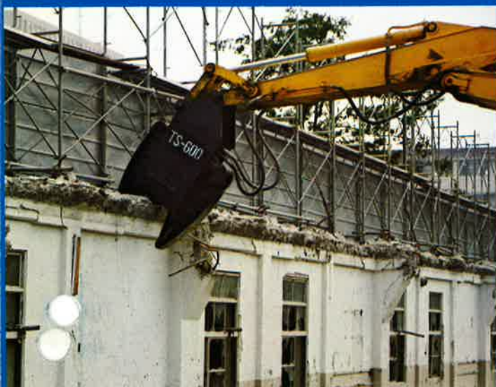
▼ 外カベ、縁切りの連続作業
