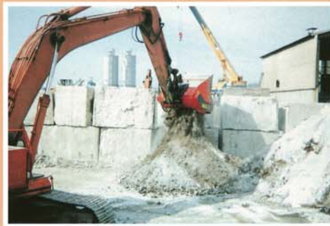
土壌改良作業
