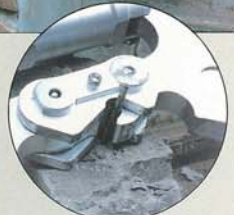
鉄筋切断もOK。
