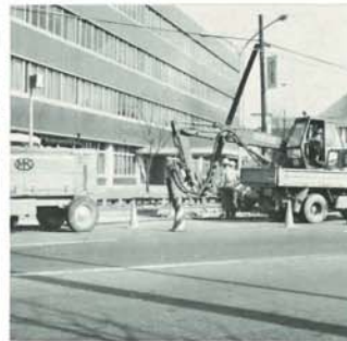
神奈川 目黒通信建設 殿
