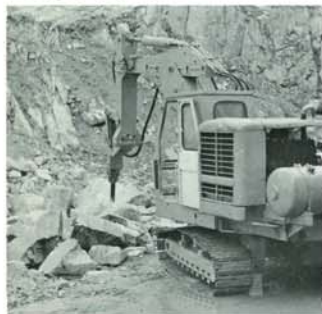
兵庫 奥村組土木興業 殿
