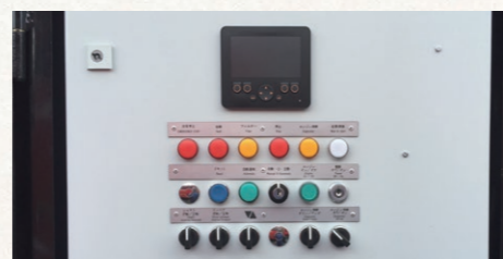
操作に必要なスイッチとランプを集中配置。視認性にすぐれ、確実な操作が行える制御パネル。
