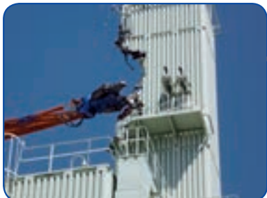
地上40mでの解体作業
