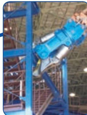
建物内の解体作業
