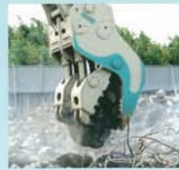
40tonクラスのコワリクン1台で、18tonクラスの3倍の処理量に!
