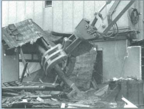
木造家屋の解体作業に
