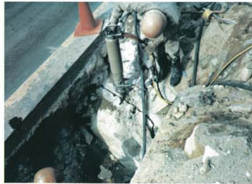
送電地中線、下水道工事での岩盤破碎(C-3)
