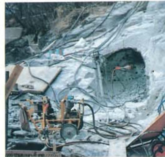
硬岩地帯での小口径トンネル掘削(C11SL)
